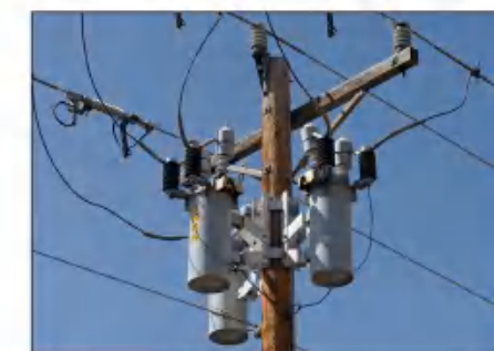
加拿大柱上式单相变压器
