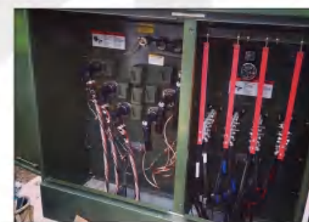
洪都拉斯太阳能电站美式箱变
